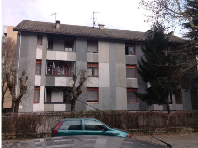
Fig. 2 TRC per pannelli di isolamento termico di edifici poco coibentati
