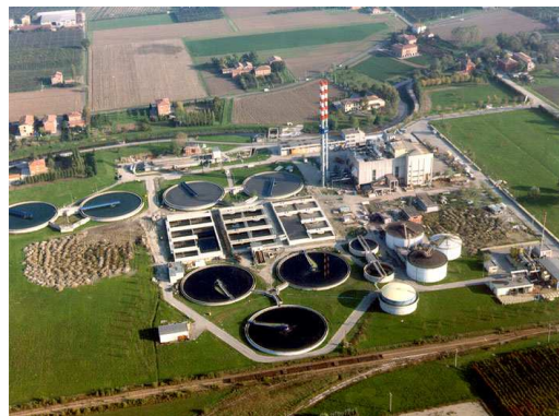
Impianti di depurazione
